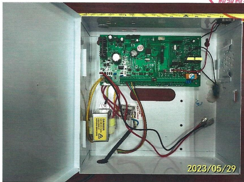
图二、SS-8120 防盗报警控制器内部结构
